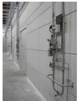
Vanne de section à préaction SEM-SAFE® sur Equinix AM3.
